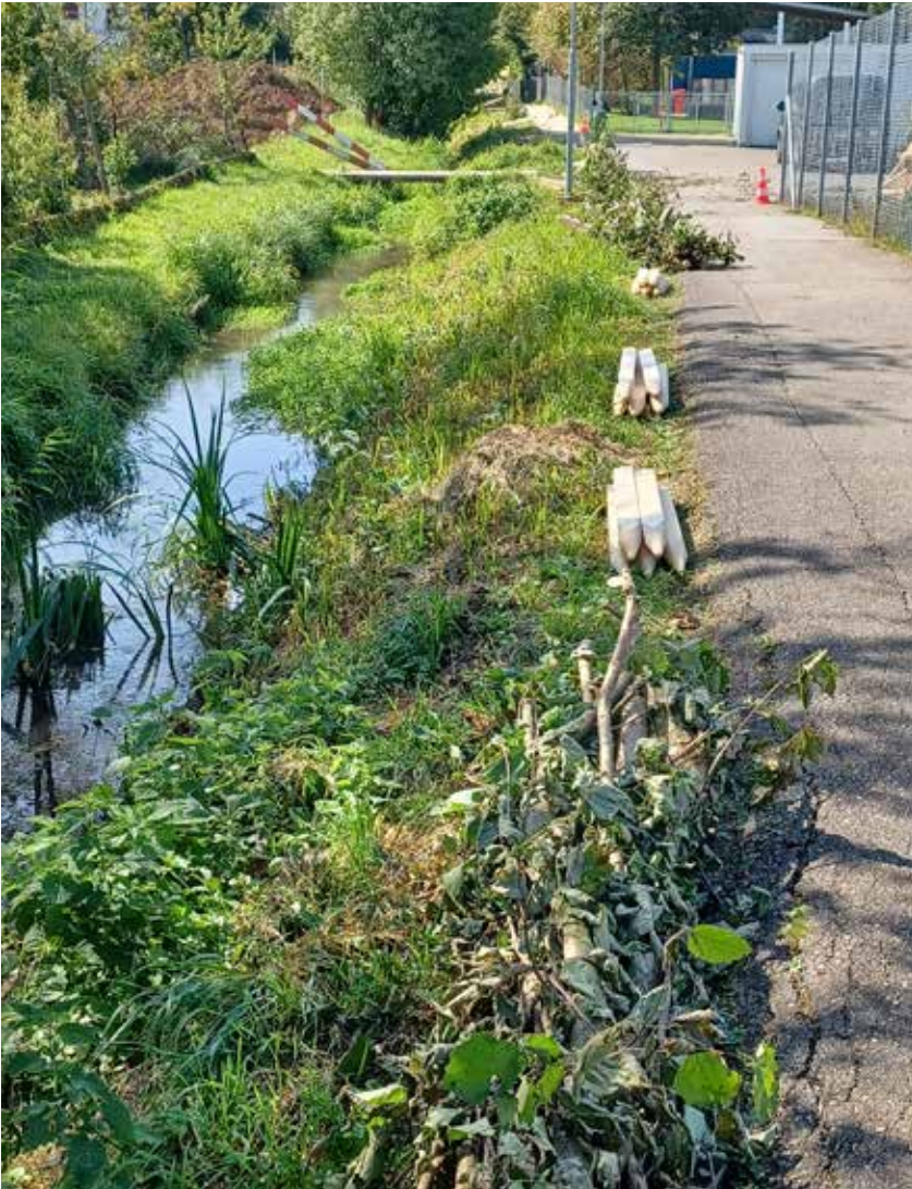
▲ Bereitgestelltes Material für den Einbau im Gäubach
