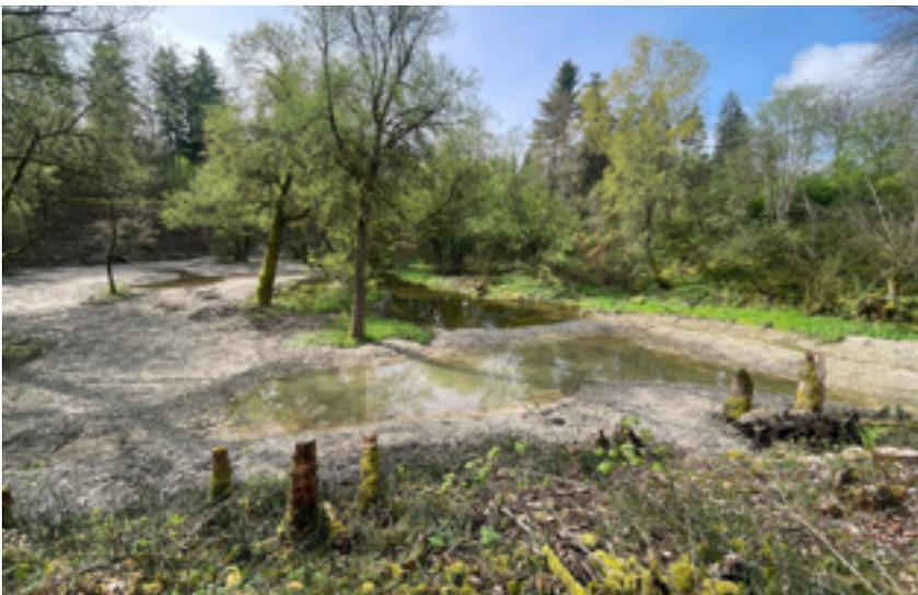
▲ Neue abflussfähige Tümpel wurden gebaut, bestehende Tümpel neu modelliert und andere mit Pressschlamm abgedichtet
