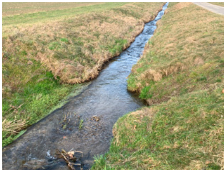
▲ Im Vordergrund der im Oktober 2023 beidseitig realisierte Rückbau der Böschungsfusssteine auf 2m Länge.
