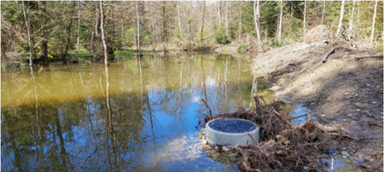
▲ Der reaktivierte oberste Weiher mit Grundablass (Mönch) Quelle: Pro Natura
